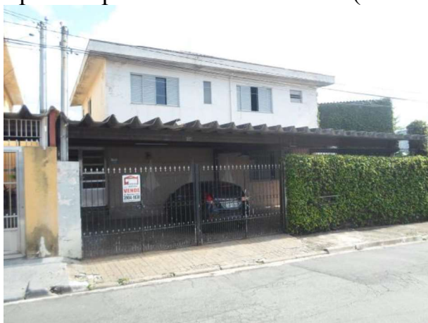
Foto: Fachada frontal.
