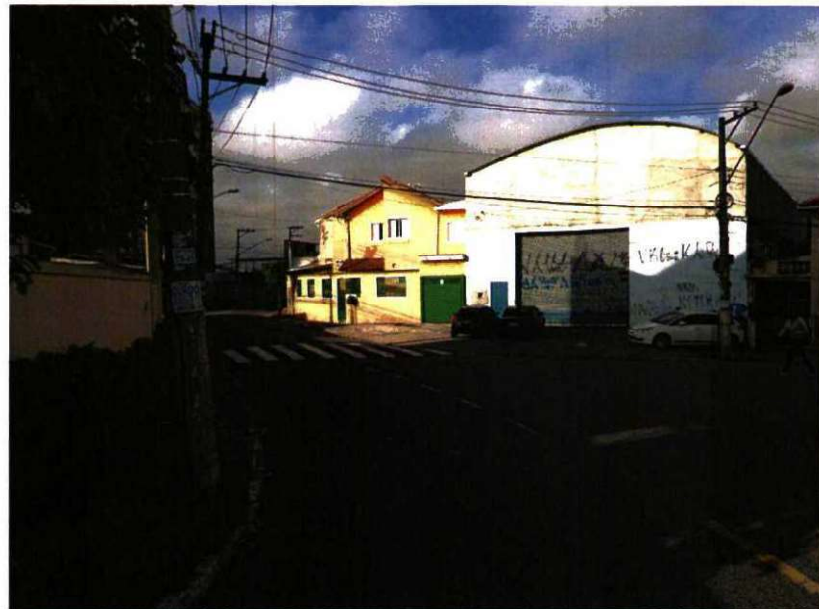
FOTOS 1/2: Vista da Rua Epaminondas Melo do Amaral , lado direito e esquerdo do local do imóvel avaliando.
