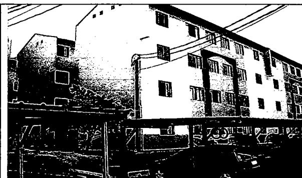
Foto 06. Vista da fachada do bloco
