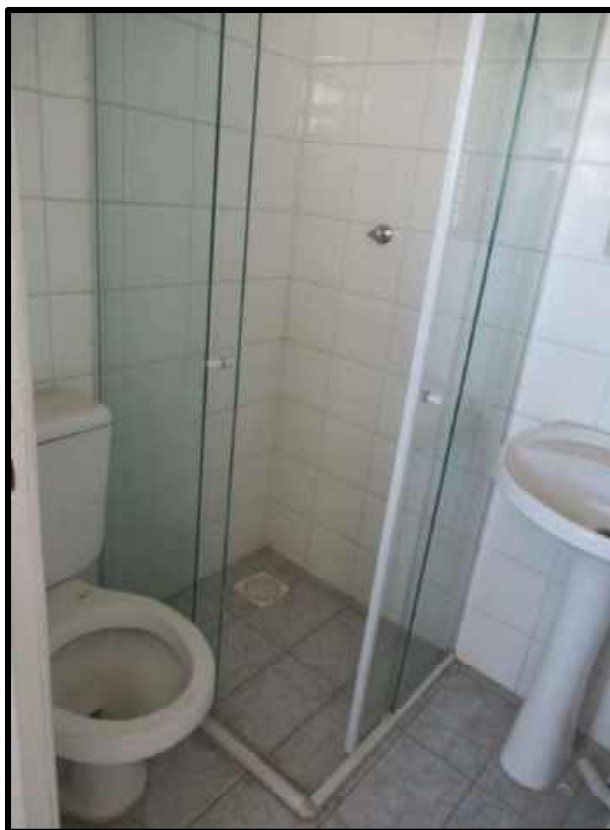
Foto 16: Banheiro de serviço
