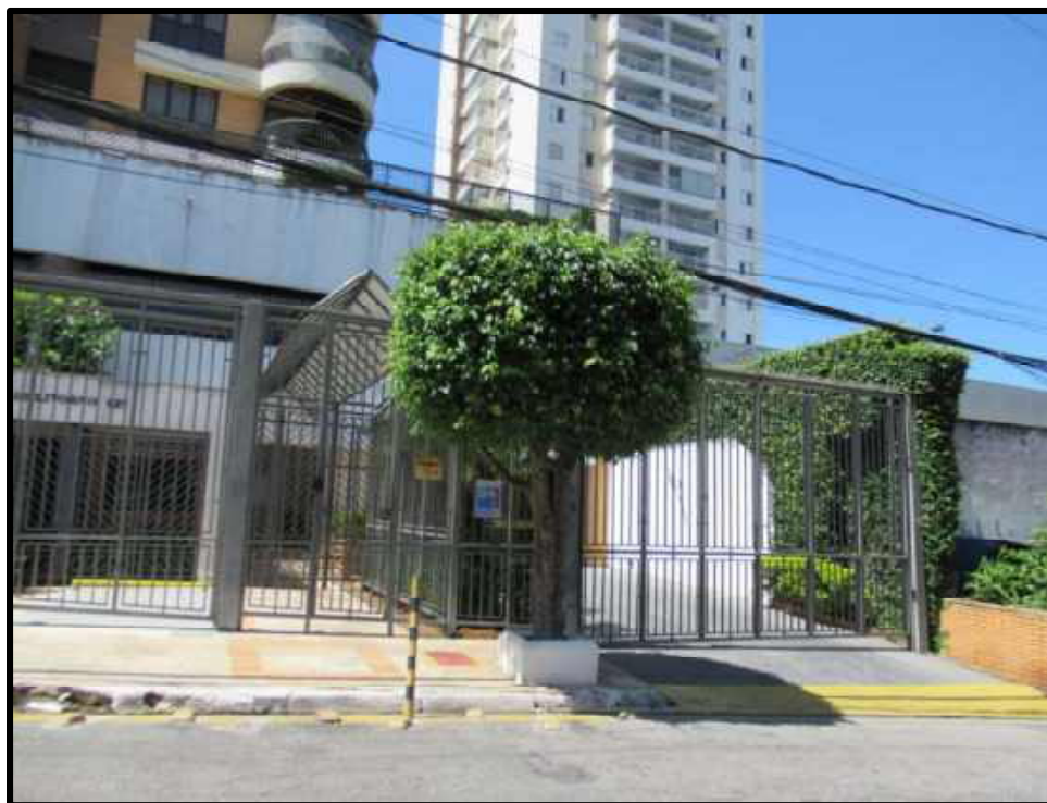
Foto 3: Entrada da garagem
