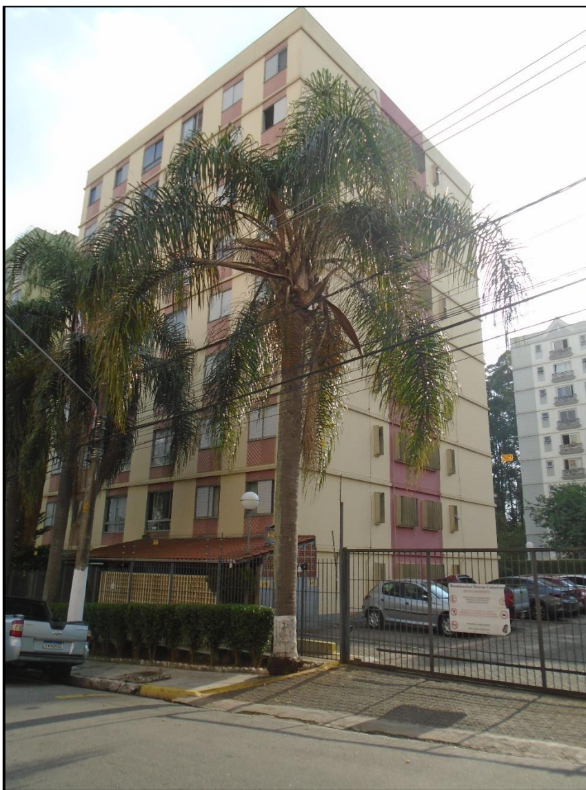
FOTO 08 – FACHADAS DO BLOCO I .
