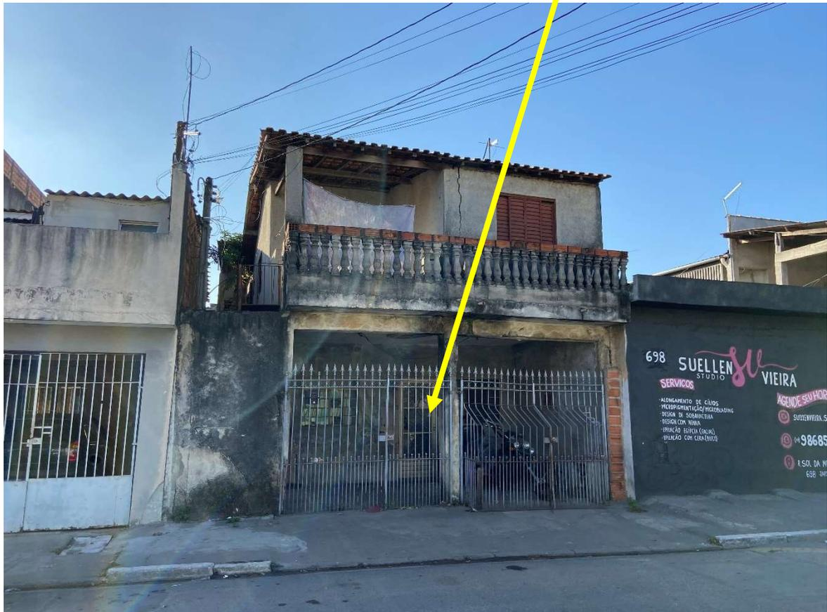
**FOTO 4:** Vista aproximada da fachada do imóvel avaliando, destacando uma grave trinca, denotando o péssimo estado da edificação.
