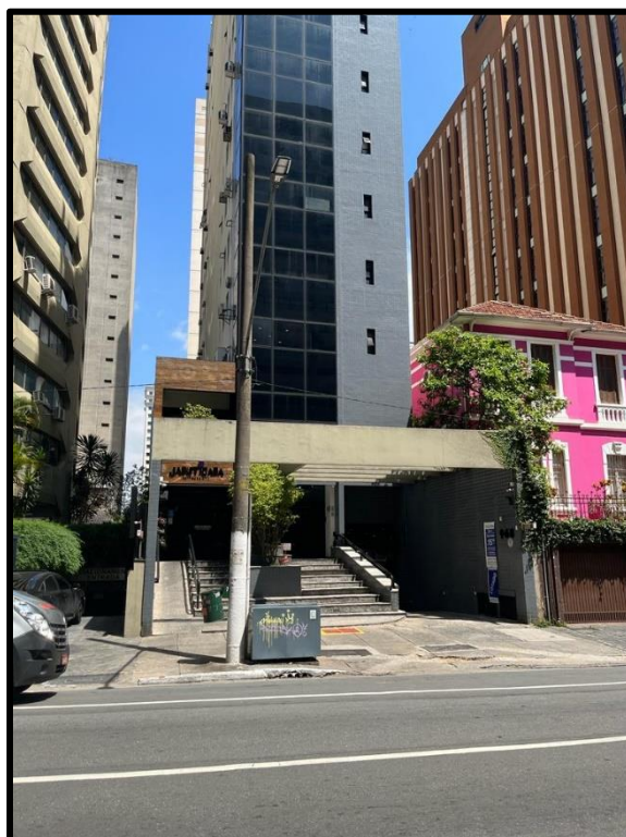
Foto 1: Condomínio Edifício Quartier Office Center
