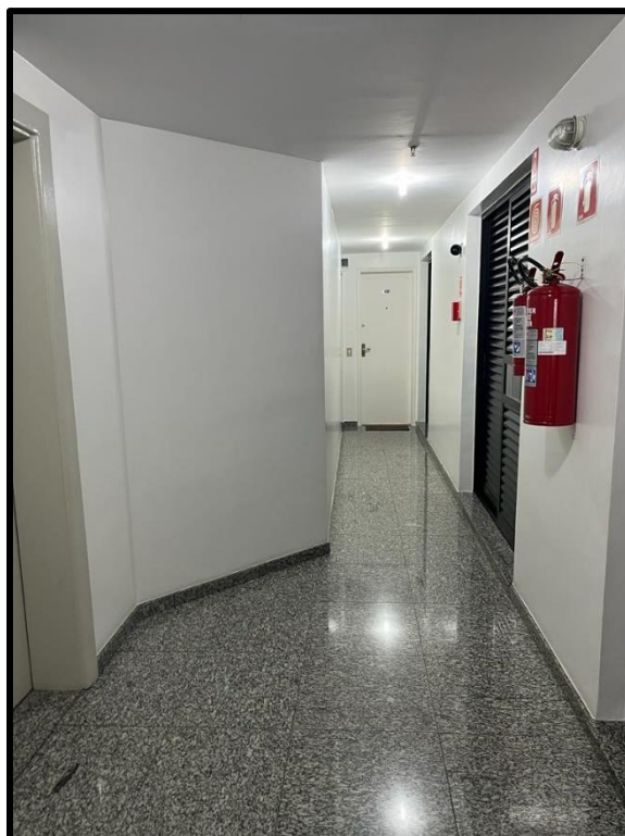
Foto 4: Circulação do 8º andar
